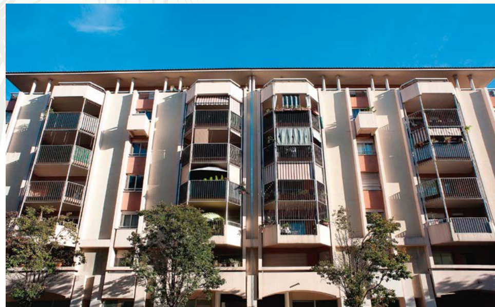
Vue sur le bâtiment C depuis la rue Auguste Gal
