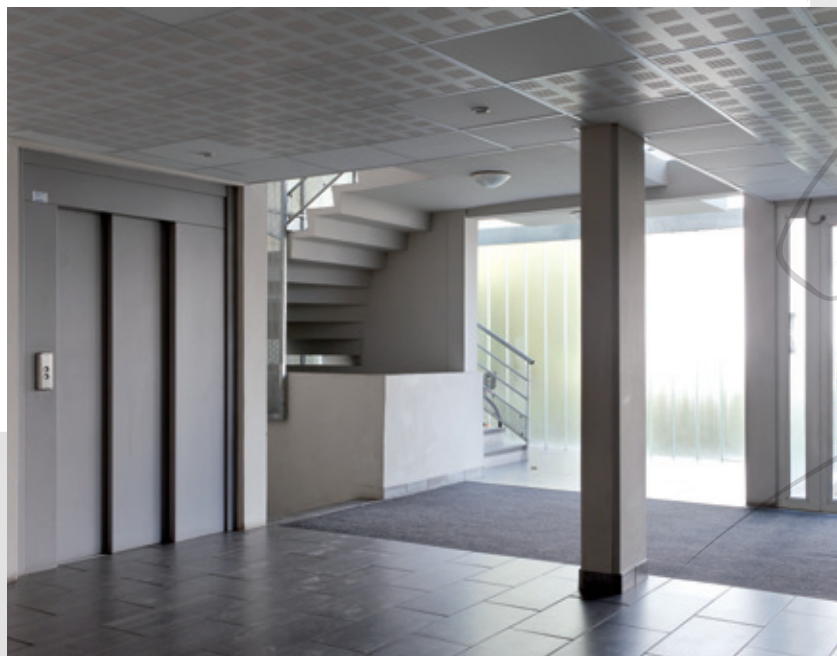
Hall d'entrée et parties communes
