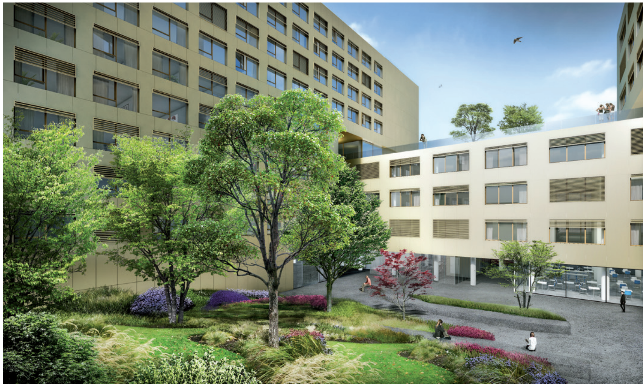
Vue du jardin intérieur
